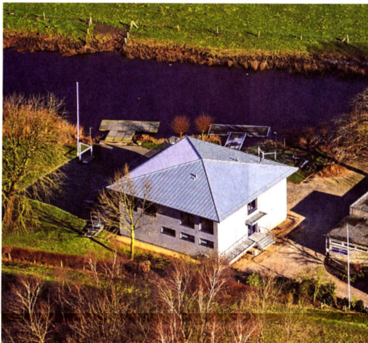
Das neue Vereinshaus der Ruderer liegt direkt an der Kückau in Elmshorn.
